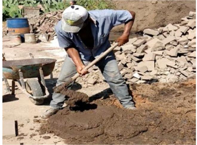
**Figura 1.** Proceso de mezclado manual con azadón.
