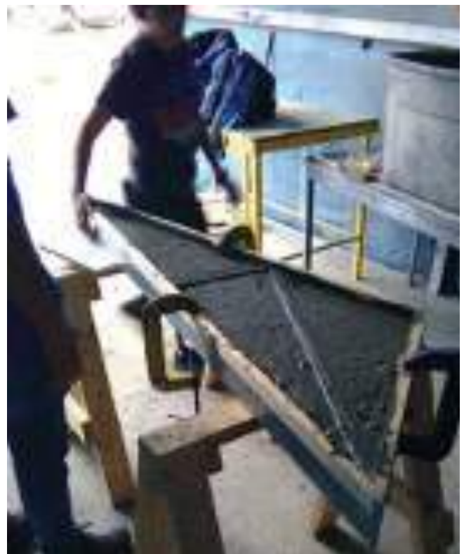
Figura 19. Colado de la cubierta
