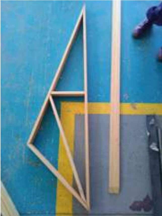
Figura 13. Detalle del marco armado para la cubierta de la banca
