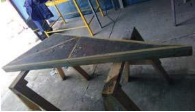
Figura 20. Desmontaje del molde de la cubierta ya fraguada
