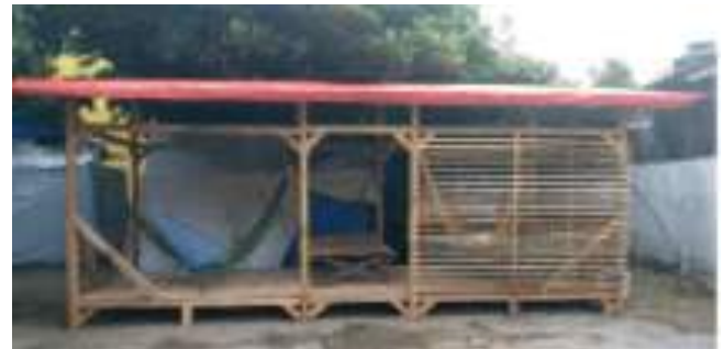
Figura 6. Prototipo de vivienda de emergencia Fuente: acervo propio, por NodoLab, 2017.
