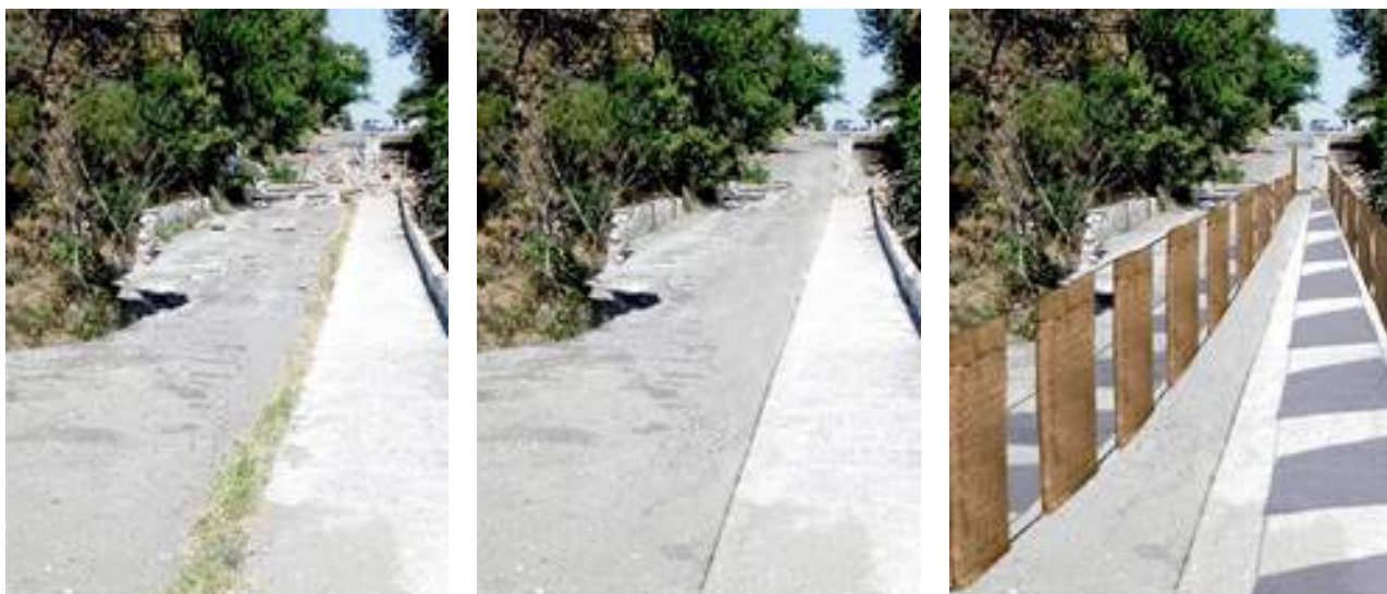
Figura 14, 15 y 16. De izquierda a derecha: estado actual, limpieza del puente y colocación de barrera física a través de costales de yute
