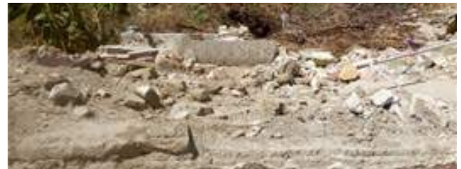
Figura 6. Escombros en el centro de Tlayecac, que alguna vez fueron una vivienda, donde se puede observar un sillón
