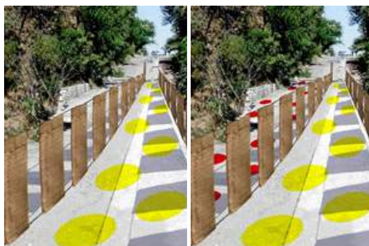
Figura 17 y 18. De izquierda a derecha, 17: implementación de pintura color amarilla en zona menos riesgosa, 18: colocación de pintura roja en zona no transitable y estado final del urbanismo táctico en el puente Viejo
