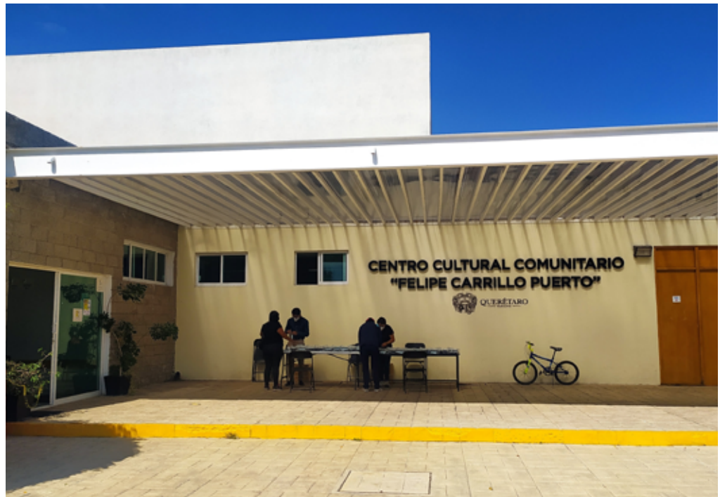
FIGURA 3. Centro Cultural Comunitario "Felipe Carrillo Puerto". Entrada principal.
