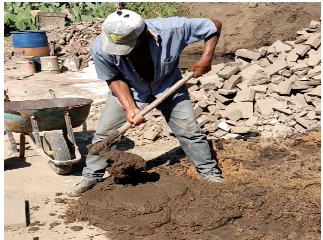
Figura 1. Proceso de mezclado manual con azadón. Fuente: Fotografía propia.
