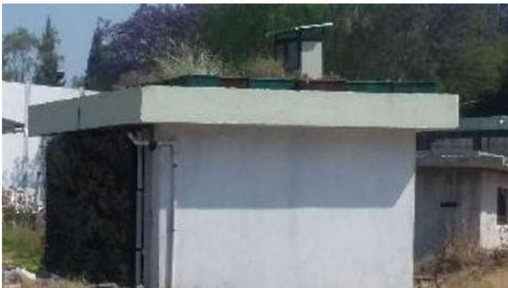
Figura 11. Caseta de monitoreo con techo baldío. Fuente: elaboración propia.
