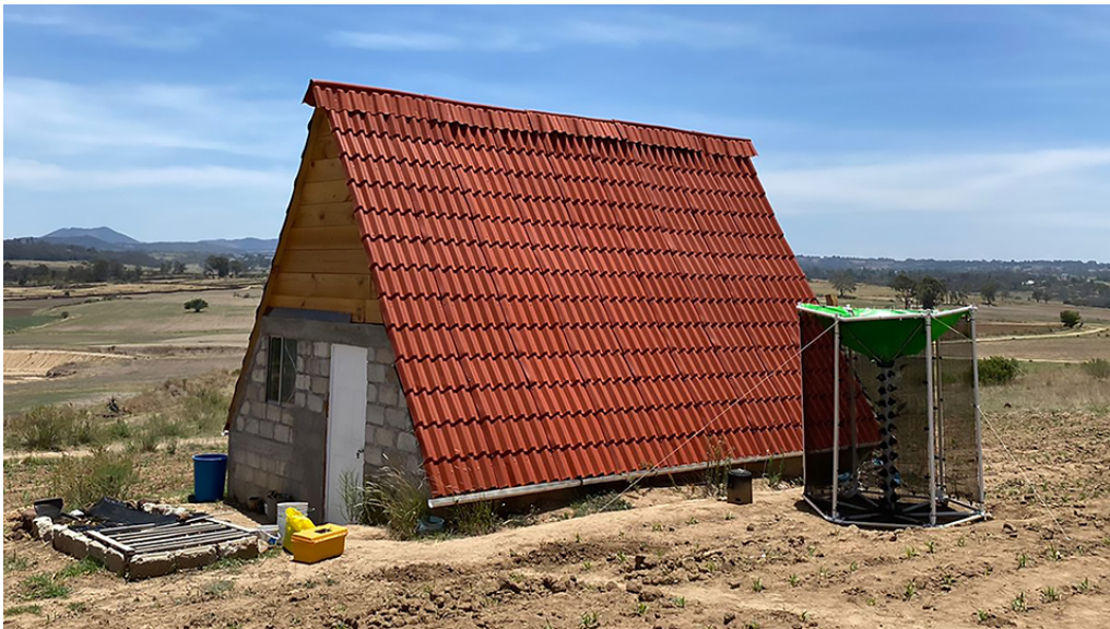
FIGURA 10. Instalación del prototipo funcional en el lugar de estudio (2024). Fuente: elaboración propia.
