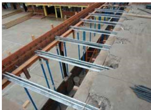
a) sistema VIGACERO® b) viga de acero galvanizado [15].
