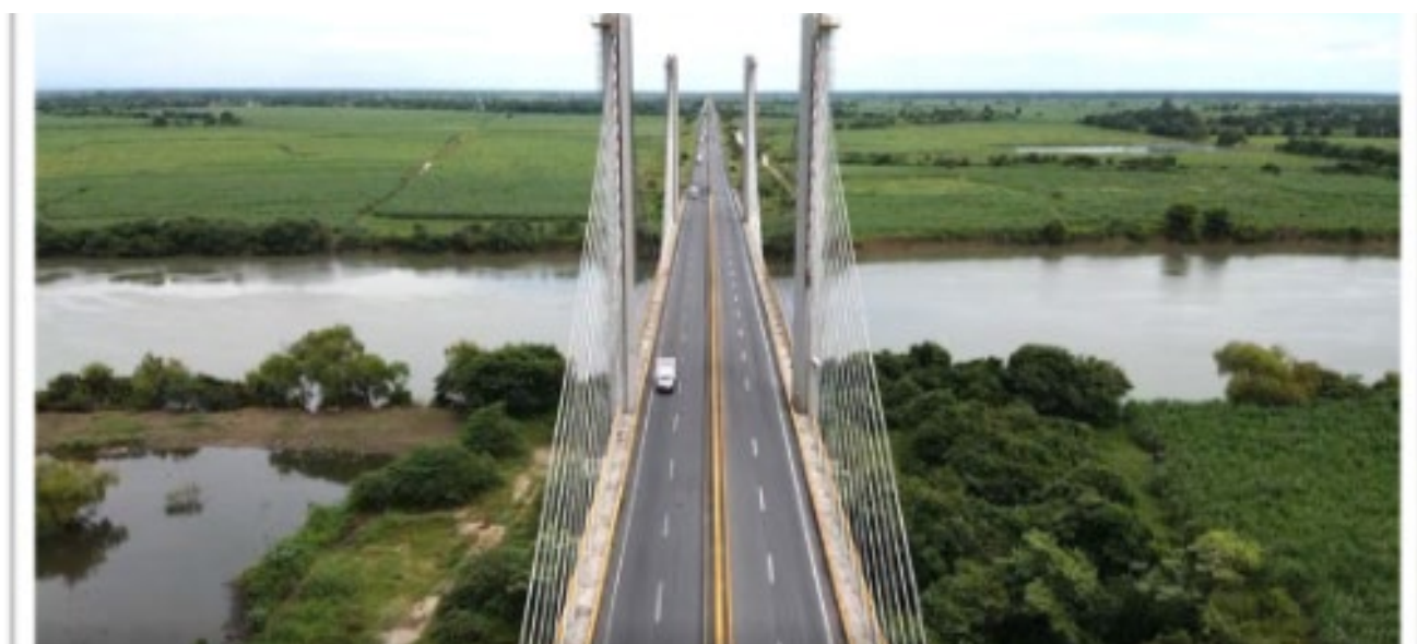
Figura 1. Puente río Papaloapan.
