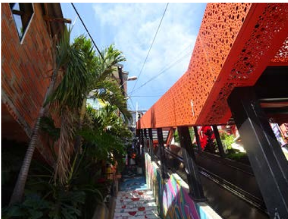
Figura 5. Escaleras eléctricas de Las Independencias I en Medellín 2 (2022).
