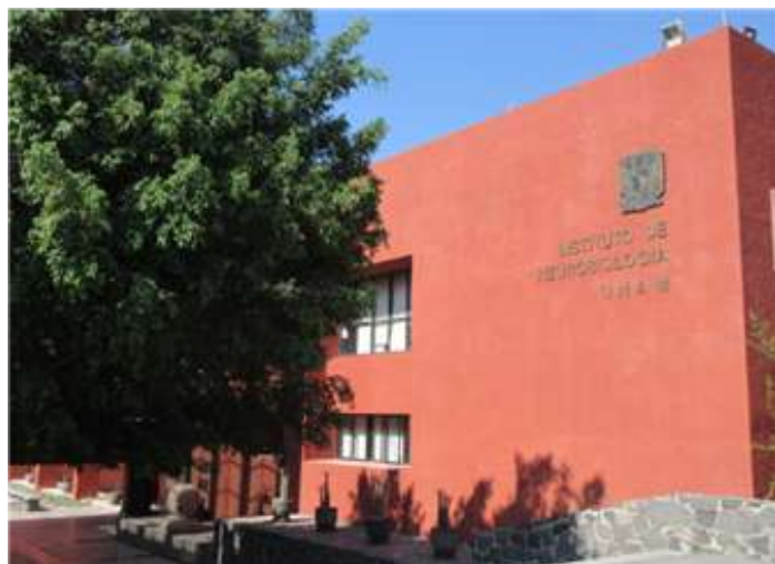
Figura 1. Vista exterior del acceso al Instituto de Neurobiología en el Campus UNAM
