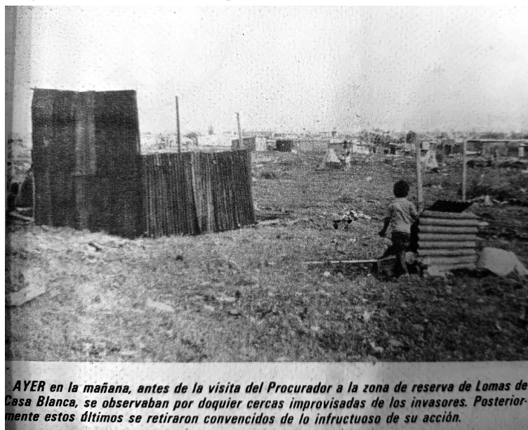
Figura 4. Panorámica de las primeras casas de Lomas de Casa Blanca
